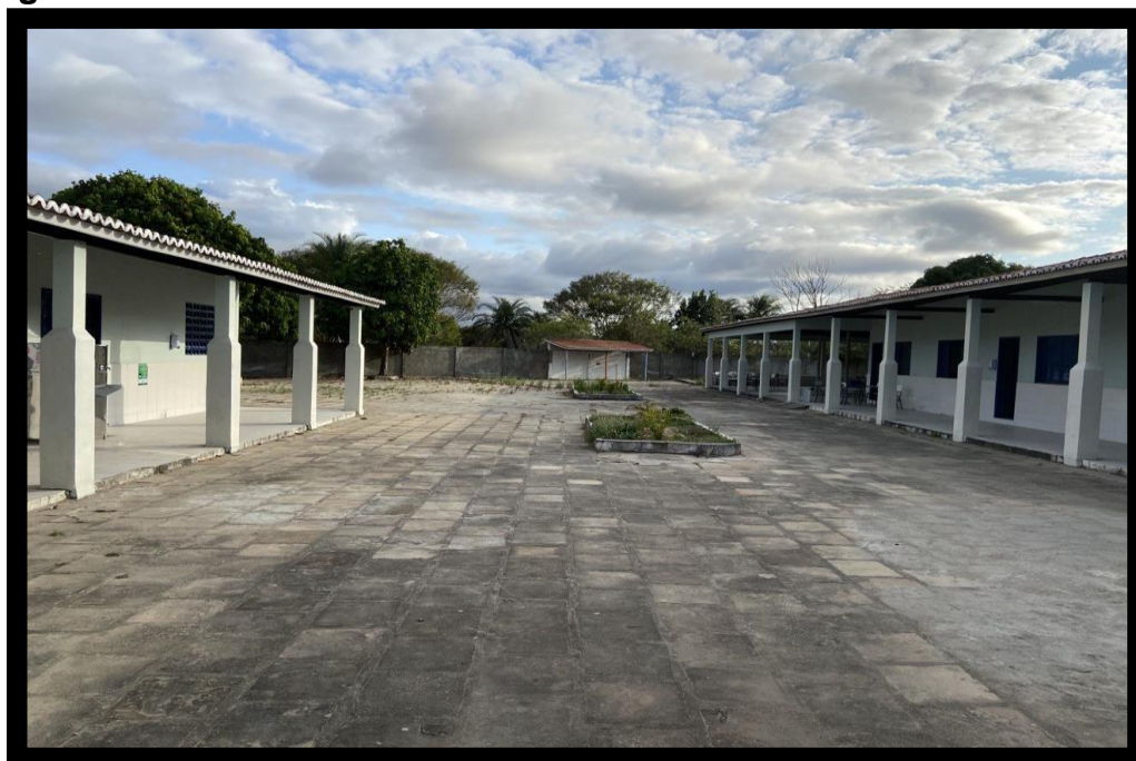
Figura 27- Vista da entrada do CEJ/ Anexo Paraíso
