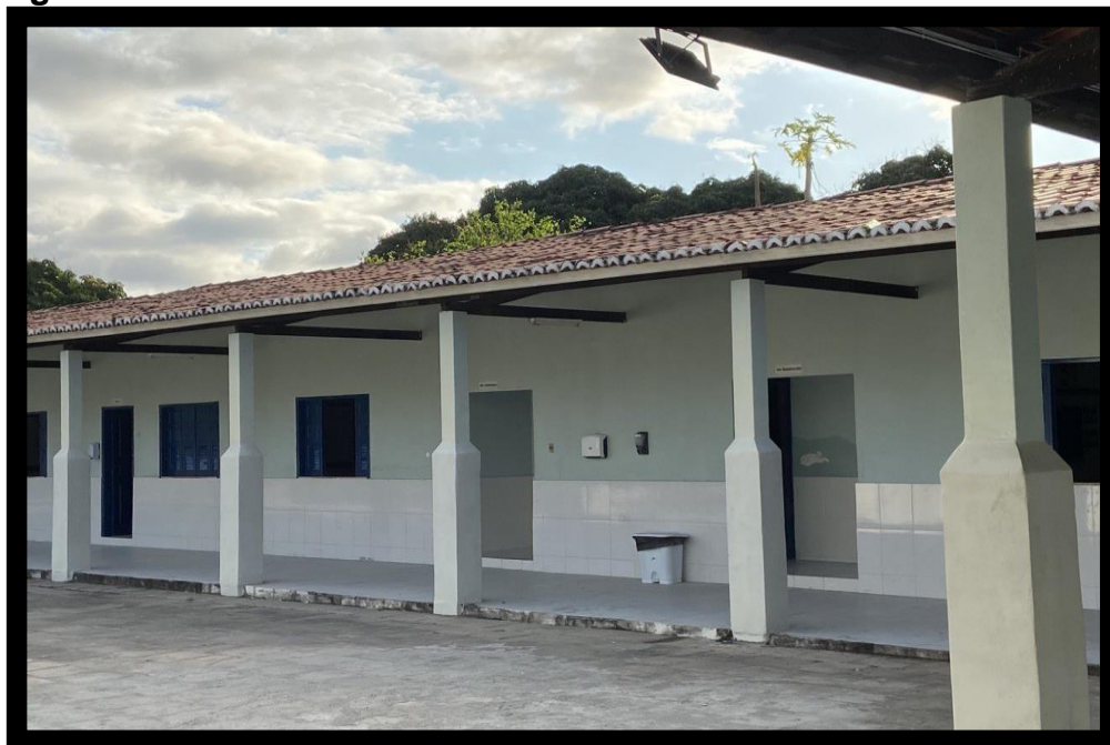
Figura 26- Pavilhão das salas
