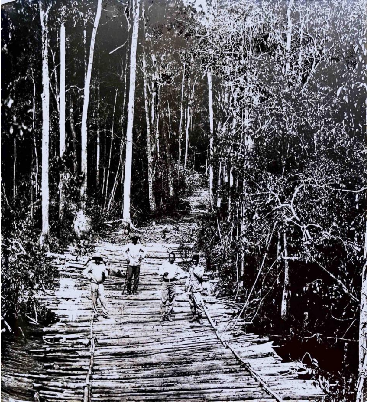
FIGURA 8 – Ponte construída sobre o rio Água Verde ou Anhanazá
