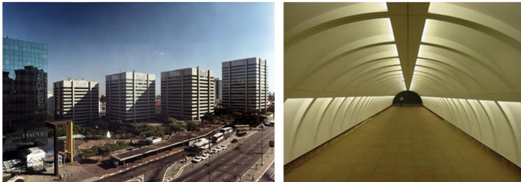
Figura 27 - a) Complexo Financeiro; b) Túnel de acesso ao metrô - Estação Conceição.
