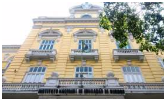
Figura 2. INES – Fachada I (atual)
