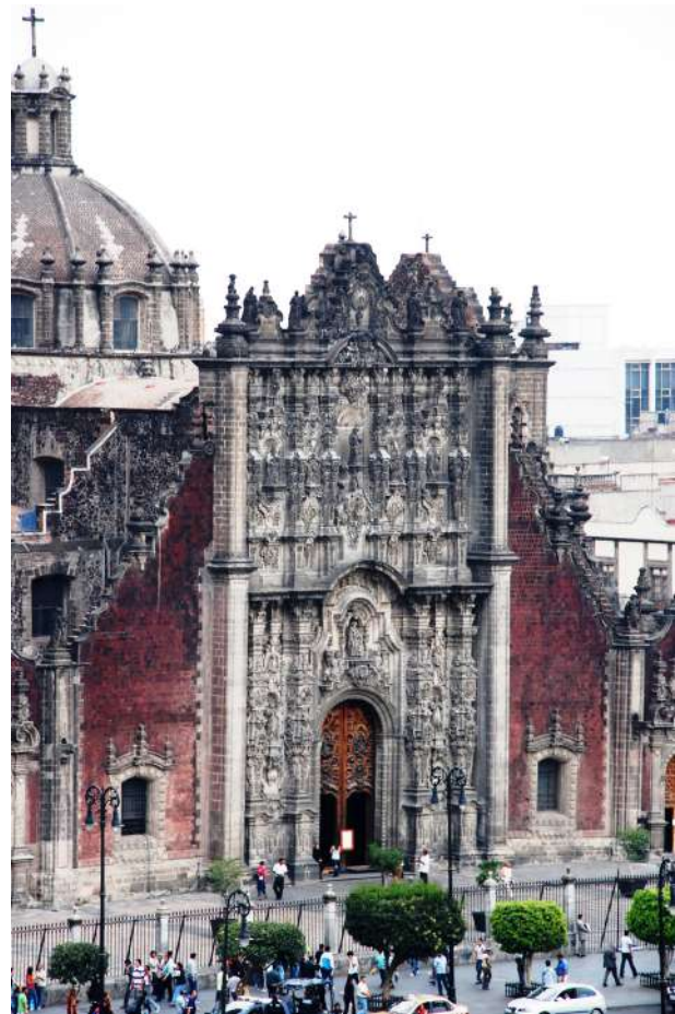
Figura 357 Uma das fachadas-retábulo constituídas por pilastras em forma de estípite lançadas no Sagrario da Catedral Metropolitana da Ciudad de México. Fonte: fotografia de Rodrigo Baeta (2009).
