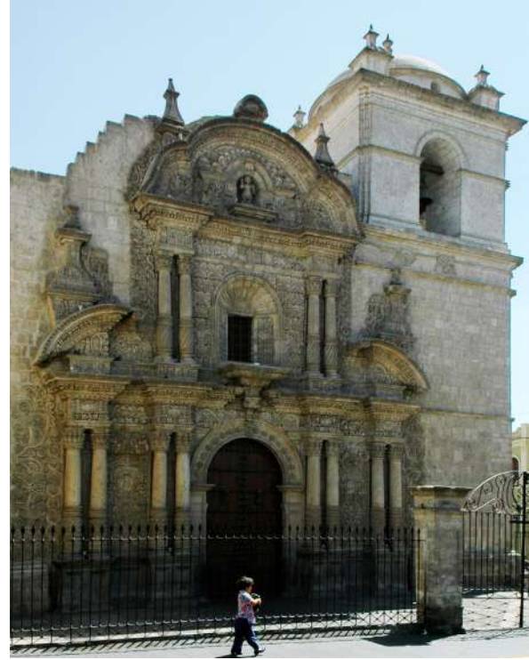
Figura 301 Igreja de La Compañía, em Arequipa. Iniciada em 1590, sob a direção do irmão Diego Felipe; mas sua exuberante fachada barroca seria esculpida pelo mestre canteiro Simón de Barrientes e concluída em 1654. Mais um exemplo da ornamentação chapada de gosto indígena, enquadrada por uma modenatura clássica reinterpretada livremente pelo estilo mestizo – formada por colunas engastadas, entablamentos salientes, arcos, nichos e tímpano trilobado coroando a frontaria.
