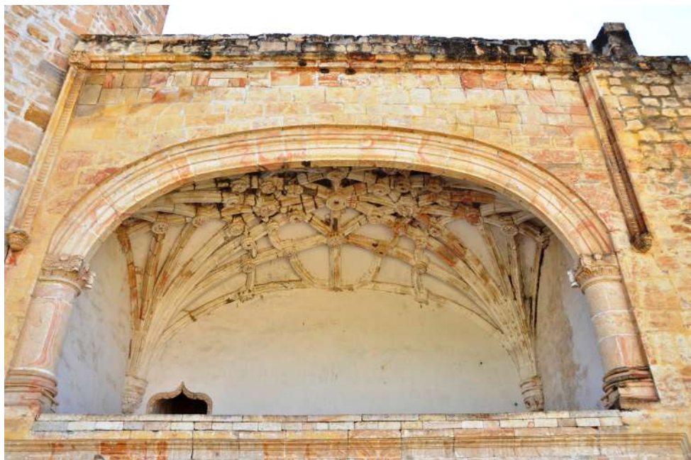
Figura 254 Detalhe da abóbada do Gótico Tardio da capela aberta de índios que se abre em posição elevada, ao lado da Igreja do Convento Franciscano de San Martín, em Huaquechula. Fonte: fotografia de Rodrigo Baeta (2013).
