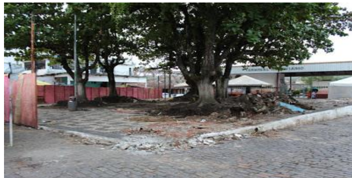
Figura 10. Pça J. Ramos antes da obra
