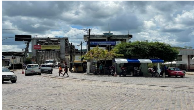
Figura 41: Panorâmica da entrada da Ponte e o mototáxi
