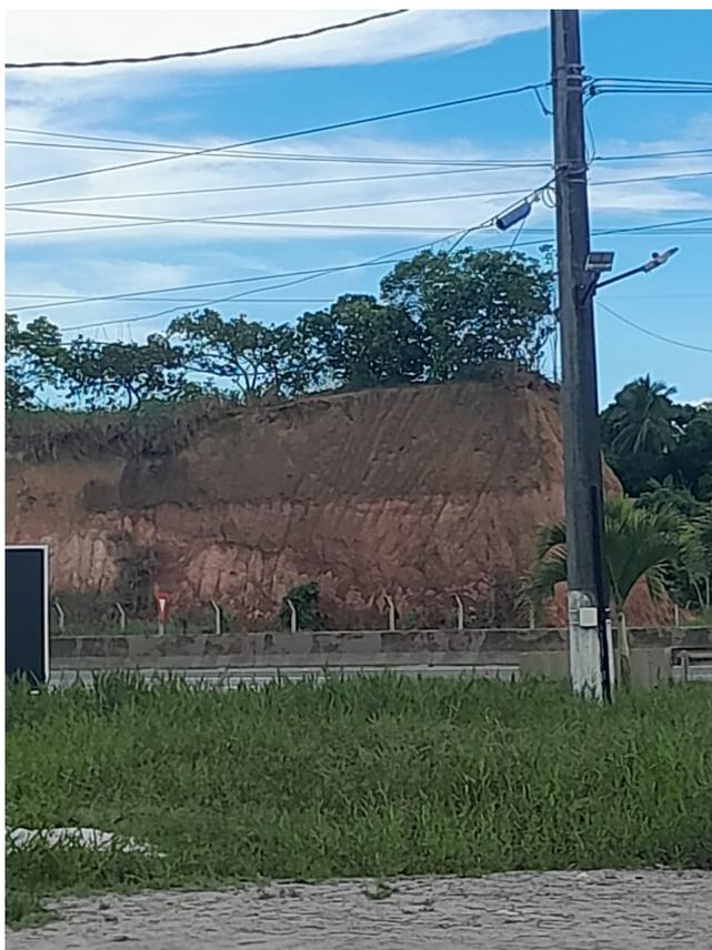
Figura 1.9: Corte de estrada próximo ao AMC na qual é possível ver duas zonas distintas de solo da Formação Barreiras.
