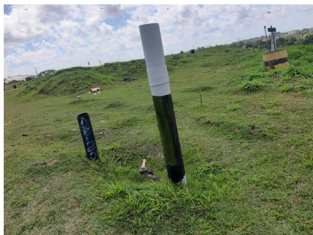
Figura 3.24: Um dos drenos responsáveis por conduzir o biogás para a usina termelétrica do AMC.
