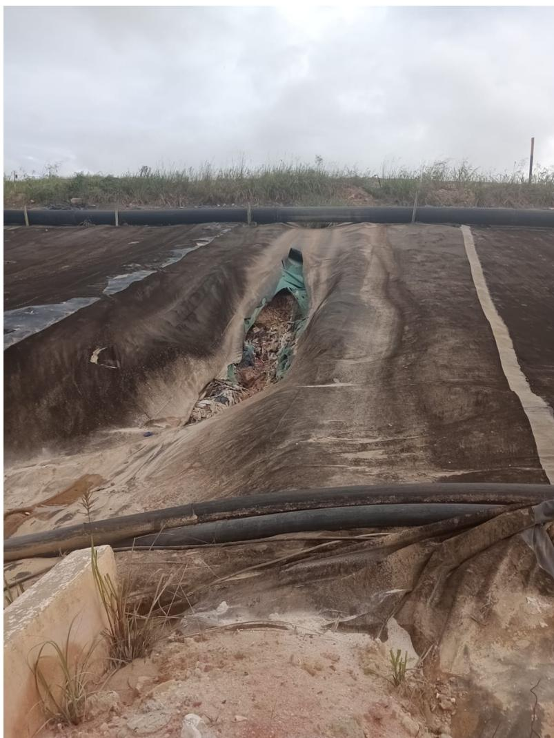
Figura 1.4: Geomanta sendo utilizada para cobertura e impermeabilização após conclusão do talude da Célula.
