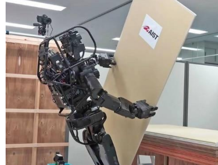
(b) Robô humanoide (HRP-5P) instalando drywall autonomamente
