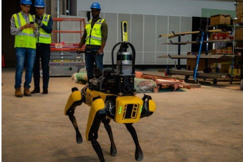
(a) Robô quadrupede inspecionando tarefas em ambiente de construção civil
