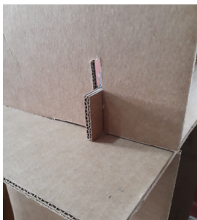
Figura 87 – Detalhe do encaixe do suporte frontal
