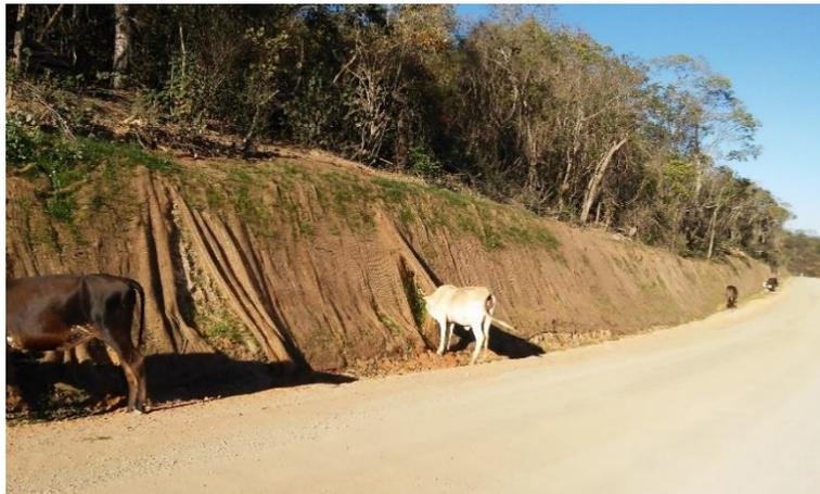
Nota: O gado persistia no acesso à serra para alimentação e dessedentação. Na imagem, nota-se o gado rasgando a geomanta aplicada pela empresa eólica com fins de contenção de erosão.
