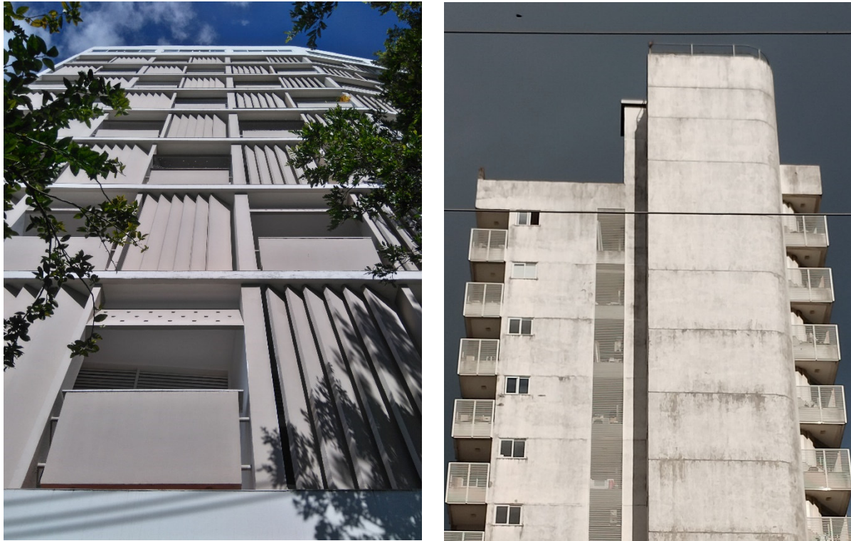
Figura 166 – Fachada poente do edifício Comendador Horácio Uripia e fachada nascente do edifício Mário Quintana (015).
