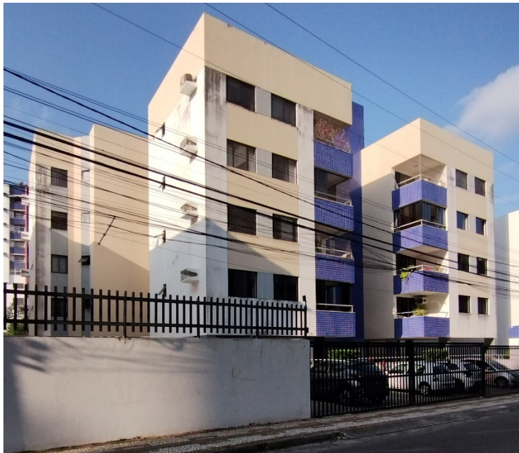
Figura 158 – Edifício Lyon (085), fachada S-SO.
