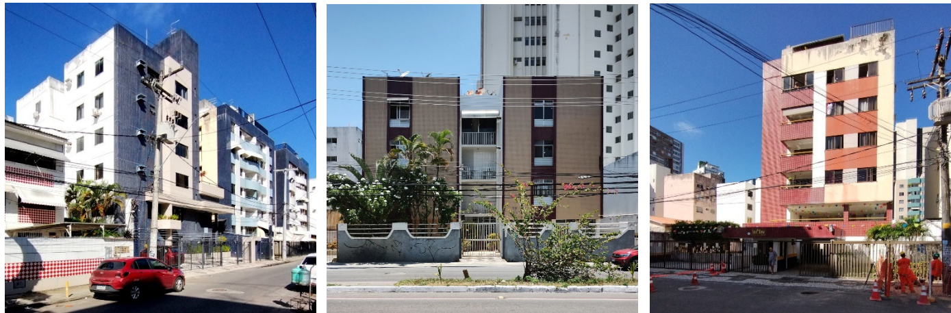
Figura 147 – Fachadas dos edifícios Jasmim (103), Luarca (136) e Ana Rosa (146).
