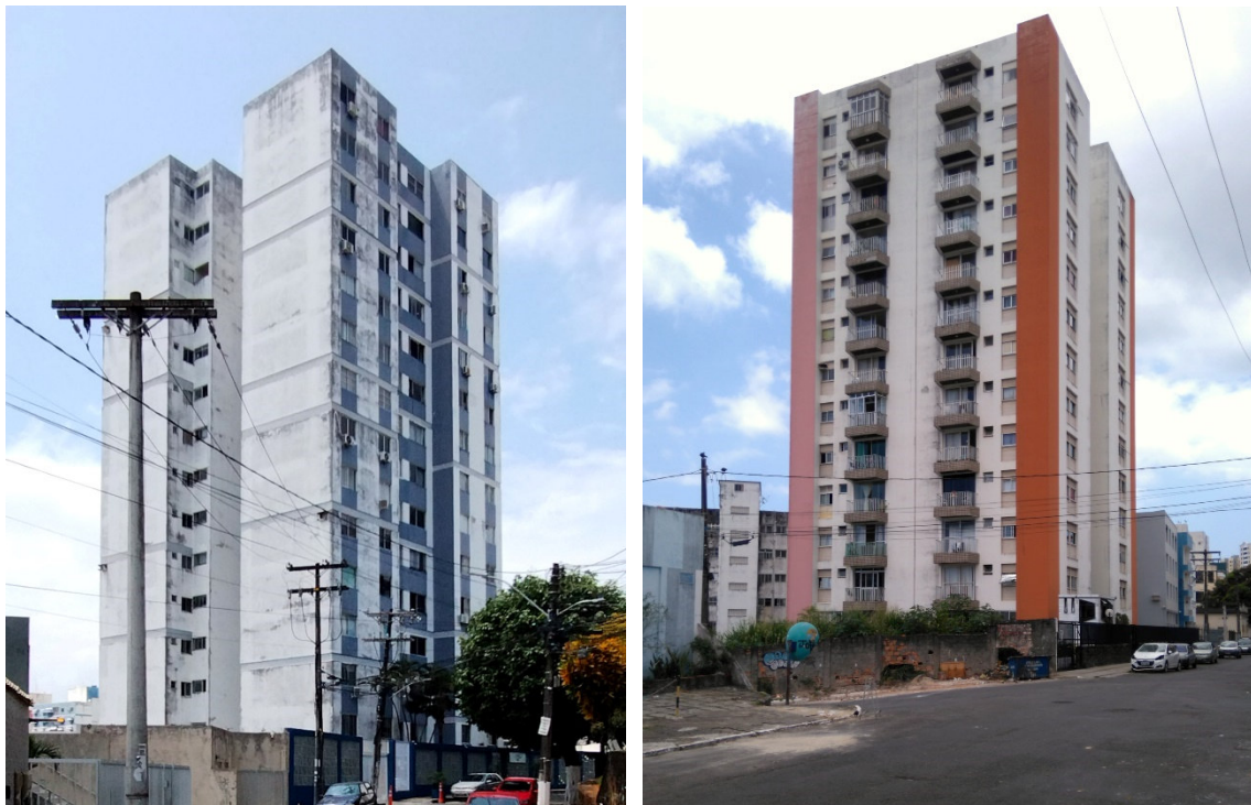
Figura 5 – Edifícios com planta H em Brotas e no Garcia.
