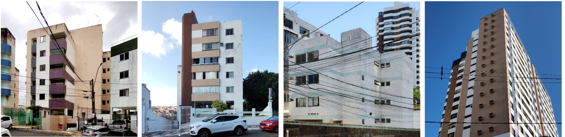
Figura 130 – Fotografias dos edifícios Maria Beatriz (038), Cidade de Iaçú (050), ambos na Vila Laura, Damcos (133) e Vila Itália (160), ambos na Pituba, representantes da implantação em lotes não regulares de modelos correspondentes ao tipo formal 3H.
