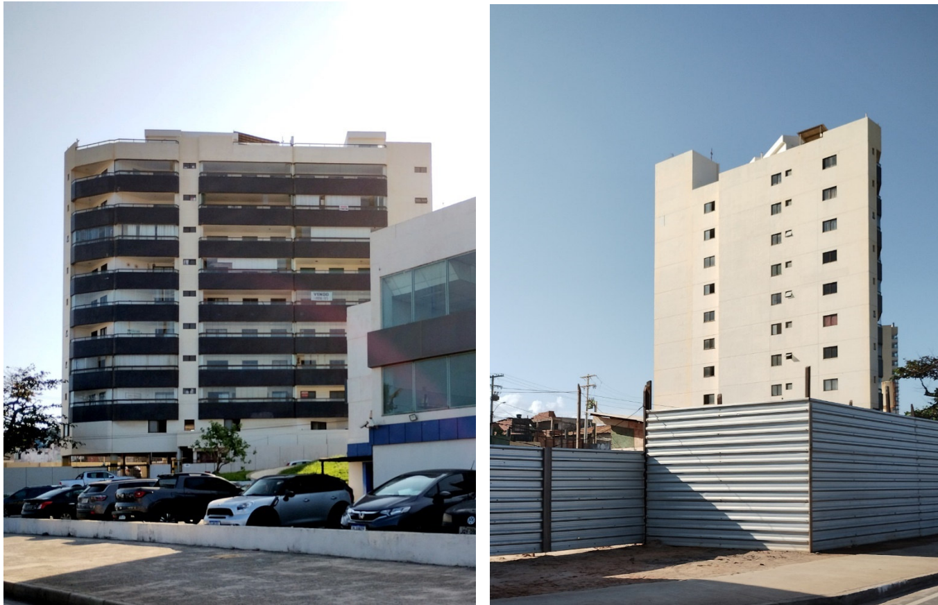
Figura 90 – Edifício Varandas do Atlântico (163), fachadas Leste e Sudoeste.
