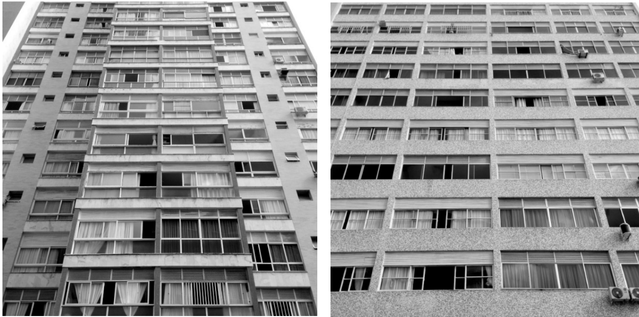
Figura 27 – Fachadas dos edifícios Vale do Iguape, com sanitário localizado entre dois dormitórios, e Maria Isabel, com sala e dormitórios em adjacência contínua, ambos na Avenida Princesa Isabel, Barra.
