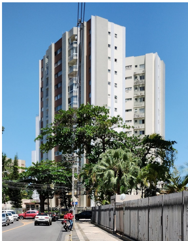
Figura 153 – Fotografias do edifício Jardim Itaigara (122).
