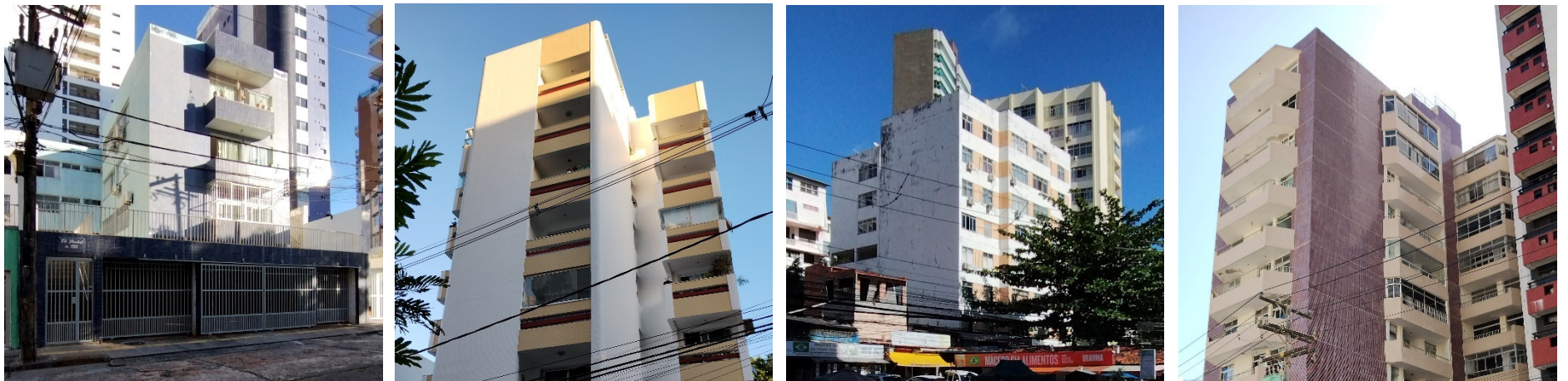
Figura 138 – Fotografias dos edifícios Rachel (010), Kennedy (014), Norma Lúcia (029) e Morada da Pituba (162).
