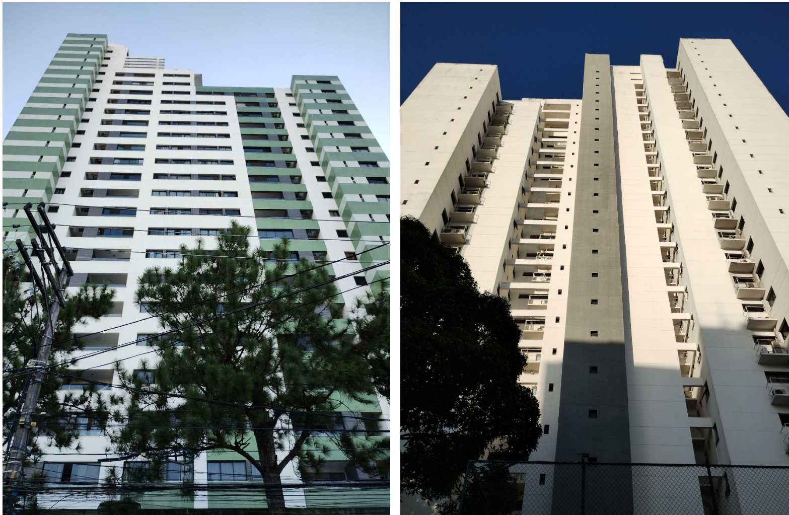
Figura 159 – Edifício Chácara Santa Maria (074), fachadas NE e SO, final da tarde, em outubro.
