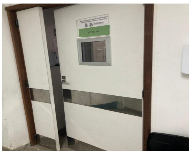
Figura 4. Porta do leito de Isolamento da UTIN
