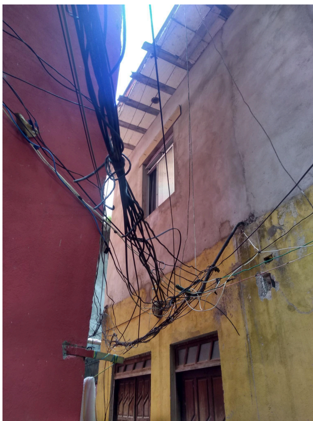
FIGURA 1. Gato de energia no Alto de Ondina, Salvador/BA - Arquivo Pessoal (2022)
