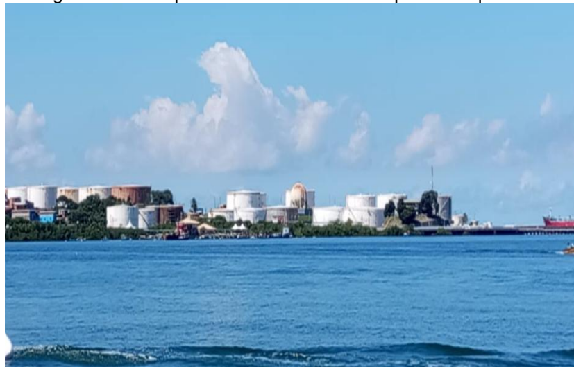
Figura 17 – Tanque de armazenamento de produtos químicos.
