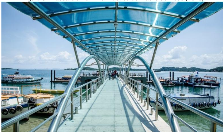
Figura 6 - Passarela Terminal Náutico de Madre de Deus (2020).
