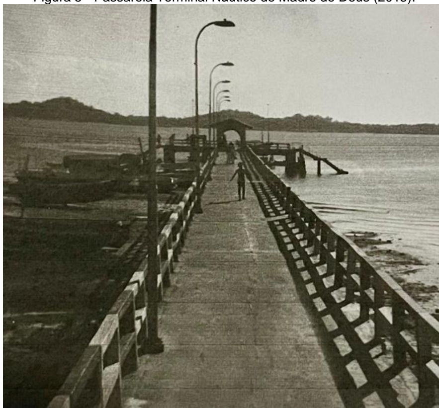
Figura 5 - Passarela Terminal Náutico de Madre de Deus (2015).
