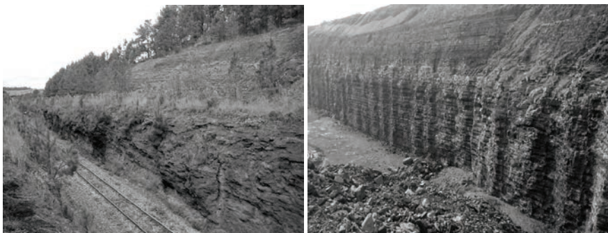
Figura 3 - Vista geral dos afloramentos coletados. Pedreira Amaral Machado, Fm. Irati (esquerda) e Fazenda Rivadávia, Fm. Ponta Grossa (direita)
