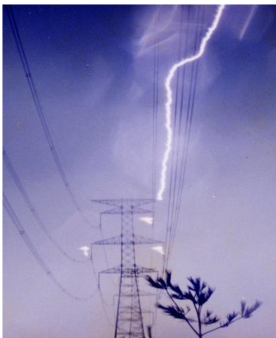
Figura 2.14 – Ocorrência de backflashover em uma linha de transmissão.
