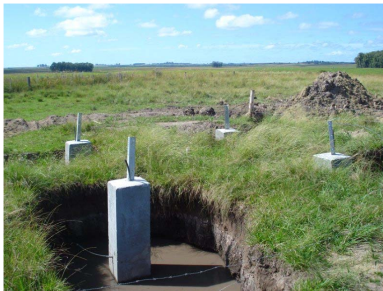
Figura 2.9 – Sapatas da fundação de torre autoportante de linha de transmissão.
