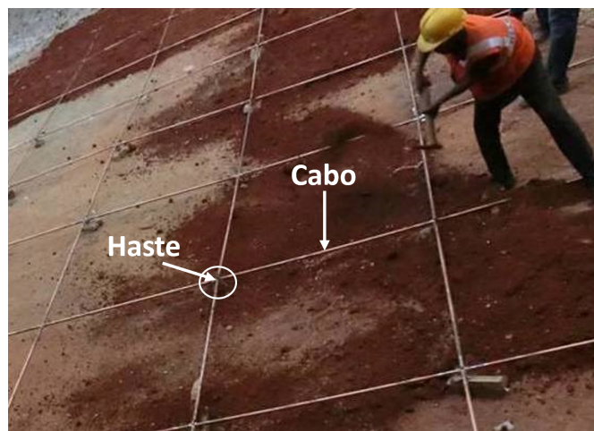
(b) Malha de aterramento
