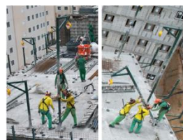
e) Transporte e montagem do poste de linha de vida
