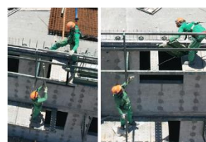
c) Instalação do piso metálico
