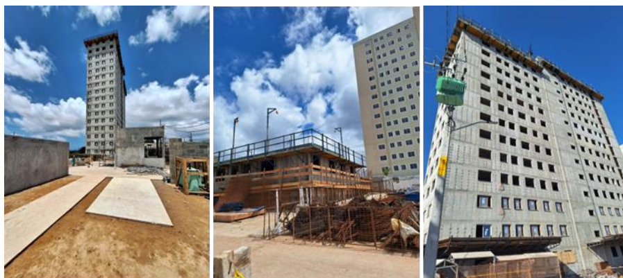
Figura 15– Fotos do empreendimento da Obra A
