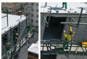
b) Instalação de passarela
