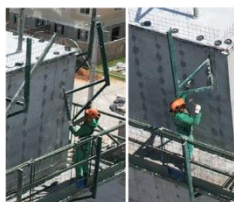
a) Instalação de mão francesa
