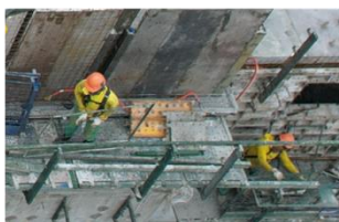
d) Instalação do guarda-corpo
