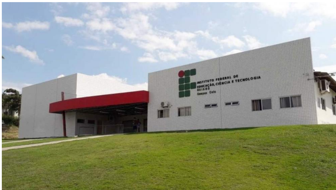
Figura 2: Fachada do Pavilhão 02 - Campus Catu
