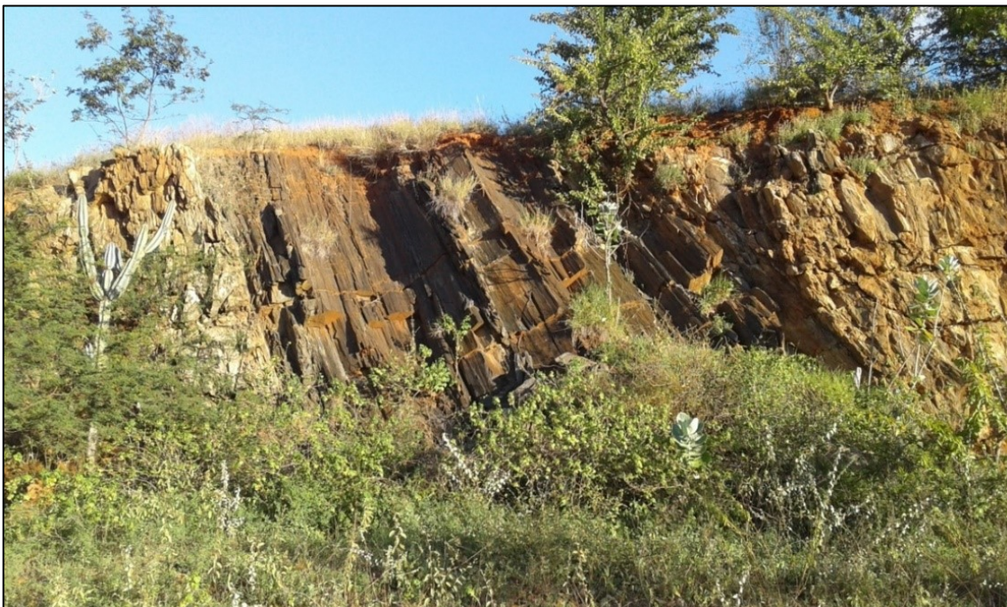
Figura 18 - Rochas máficas intrudindo rochas félsicas - Talude do vertedouro do Açude de Anagé, Limite entre os municípios de Anagé e Caraíbas
