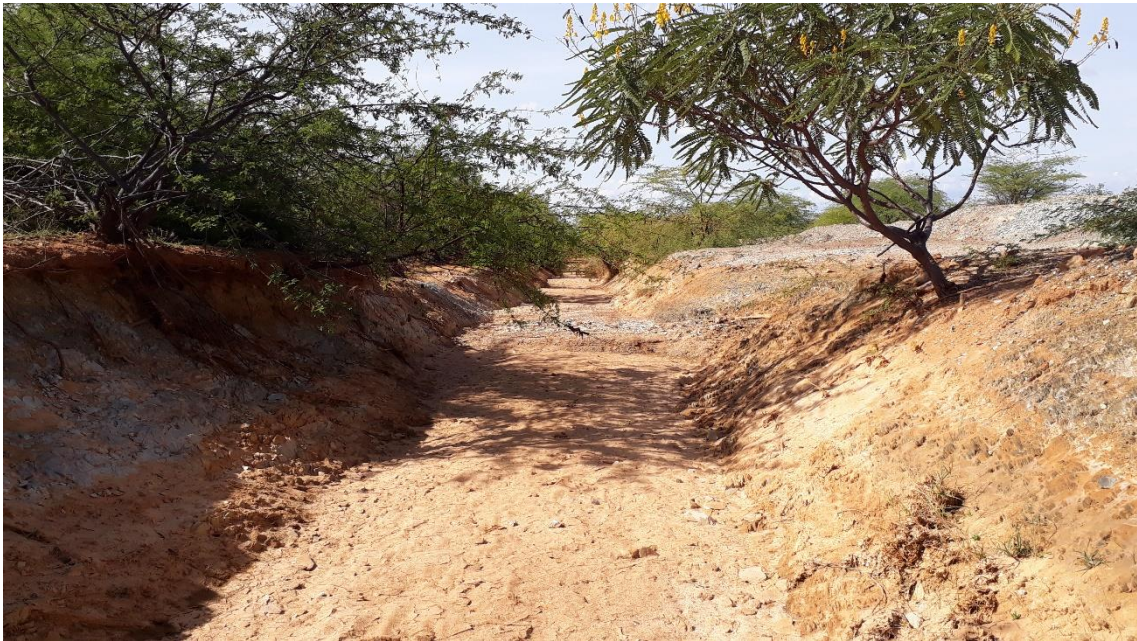
(66) Dreno – 2019 – entre Campo dos Cavalos e Curral Novo
