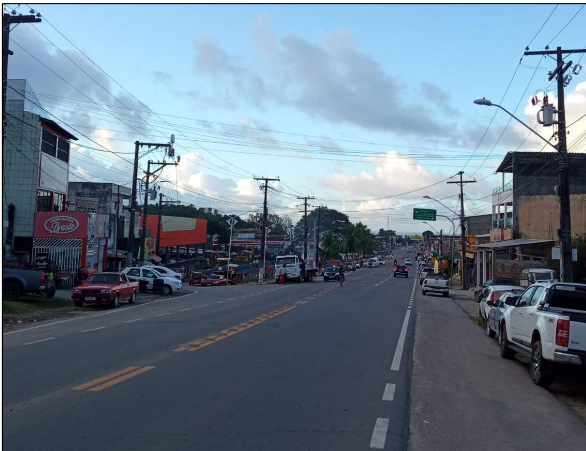
Figura 22- Fotografia do início da BA-001, próximo ao Terminal de Bom Despacho e Gameleira, 05/04/2024.
