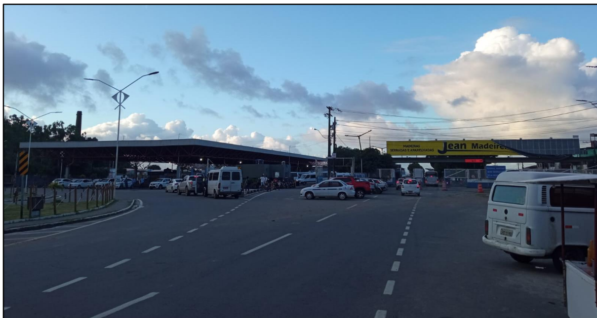
Figura 21 - Fotografia da entrada do Terminal Hidroviário e Rodoviário de Bom Despacho, 05/04/2024
