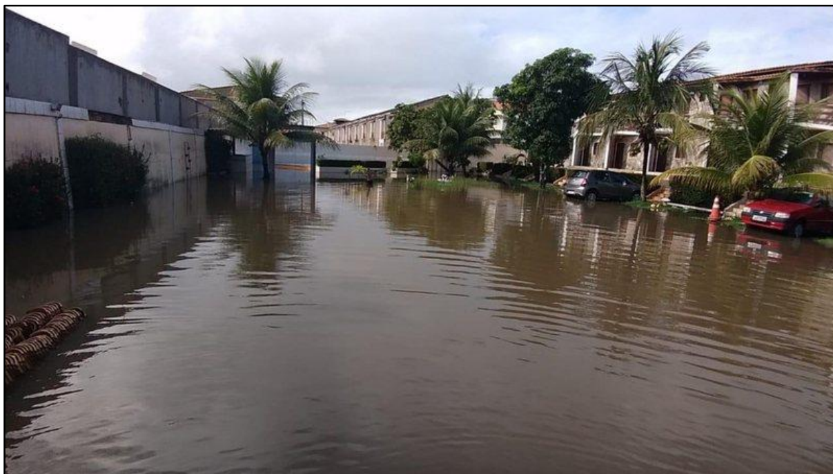
Figura 13 - Fotografia do alagamento no Loteamento Marisol, após a requalificação, 2020
