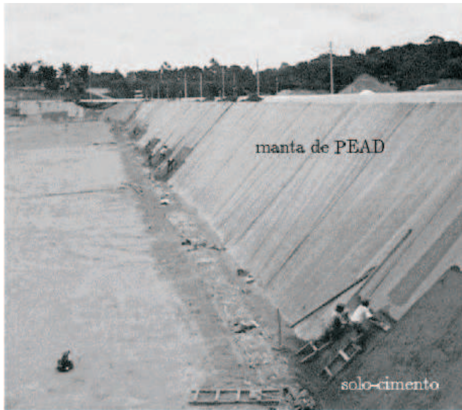
Figura 2.2: Execução de impermeabilização em uma célula tipo para disposição de resíduos industriais perigosos (Cavalcanti, 1999).
