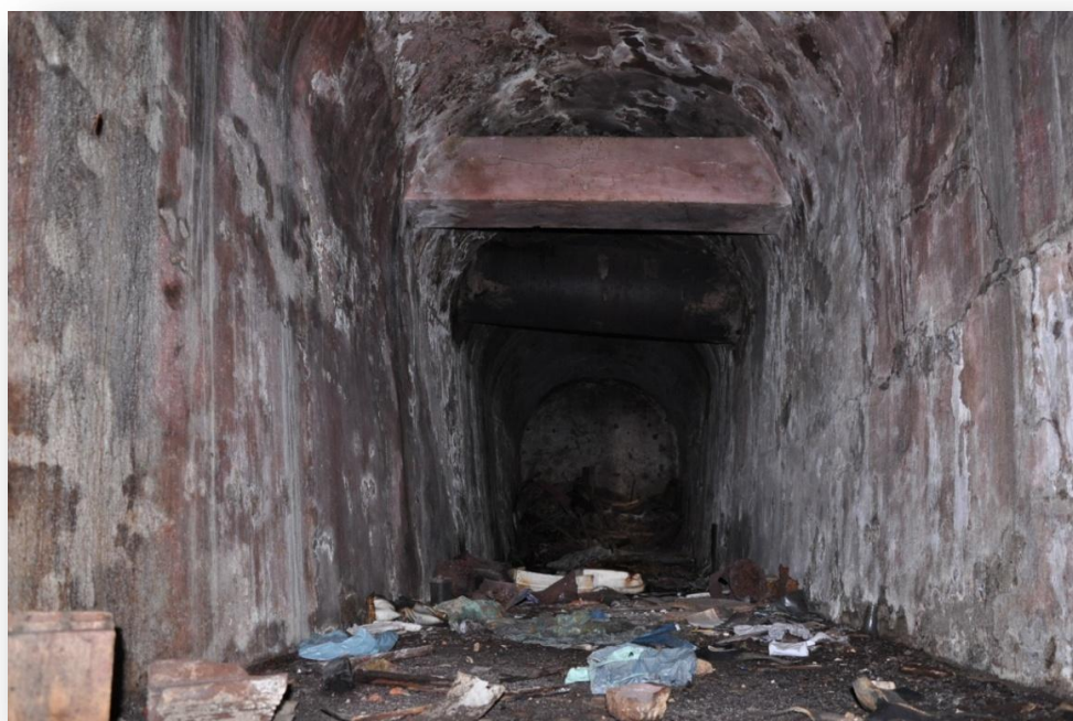
Figura 44 – Fotografia do interior da galeria.
