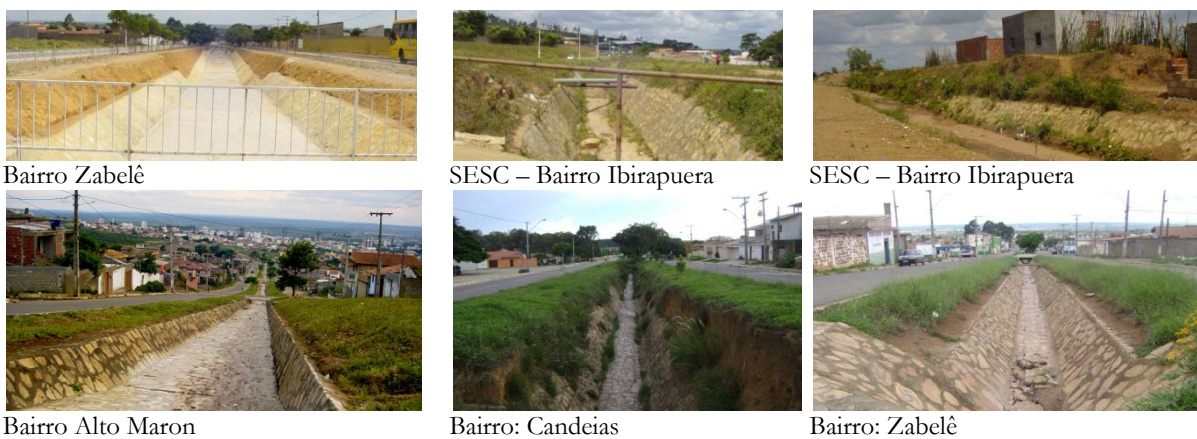
Figura 5.26 - Canais de drenagem urbana em Vitória da Conquista - BA.
