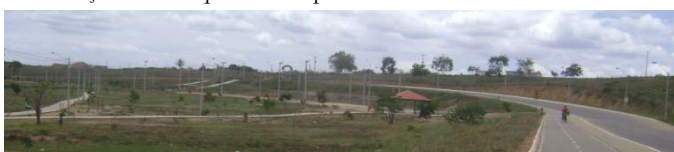
Vias de circulação e equipamentos urbanos no Parque Municipal Urbano da Lagoa das Bateias
