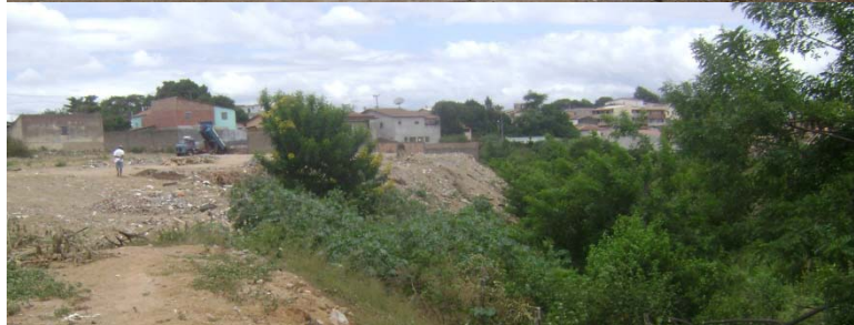
Aterro nas margens da Lagoa da Patagônia
