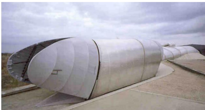
Figura 3.23: Pavilhão de Água Doce: exterior. 80
