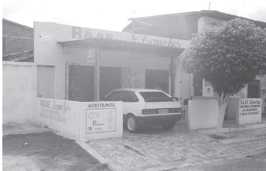
Indicação, na parede externa, que recebe Palma$
