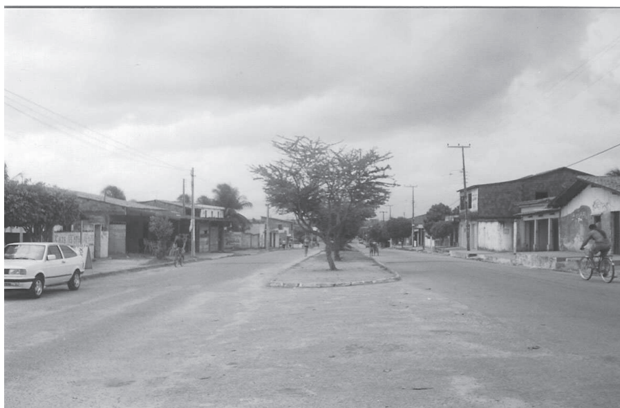
Via principal do Conjunto Palmeiras
