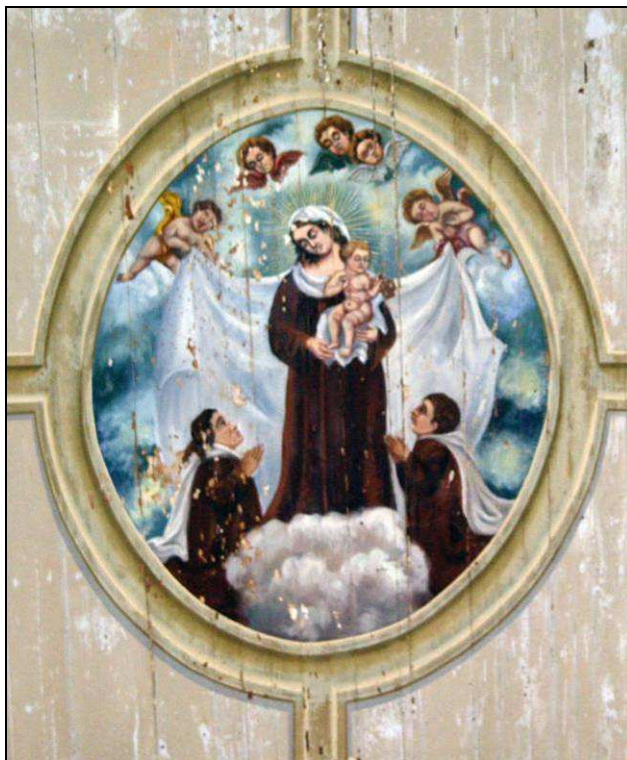
Figura 62: Repintura do teto do forro da capela-mor Fonte: Roberta Bacellar Orazem, 2007
